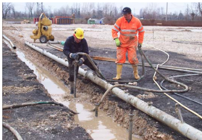
Fig.4 Infissione delle punte wellpoint con getti ah alta pressione
