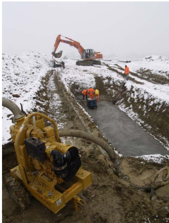
Fig.7 Drenaggio durante i lavori di posa di un metanodotto
