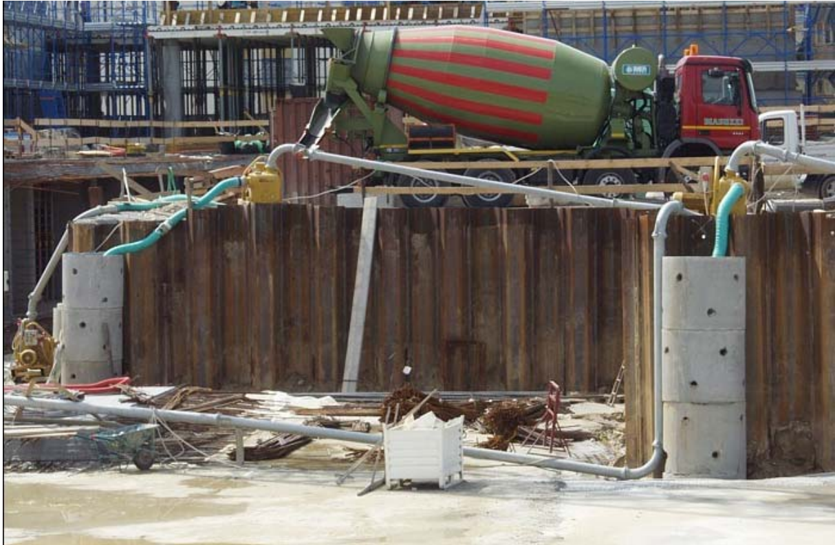
Fig.3 Prosciugamento di un'area di cantiere con pozzi auto-affondanti
