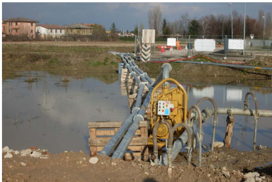
Fig.5 Emungimento e scarico delle acque con una pompa autodescante
